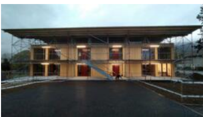
Modulbau beim Schulhaus 2
