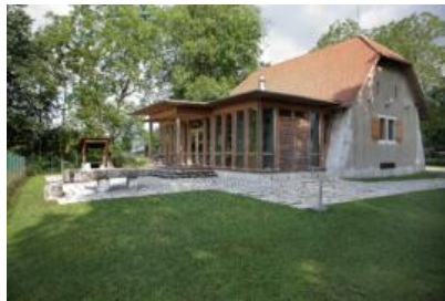
Pulverhaus, Ansicht süd ost
