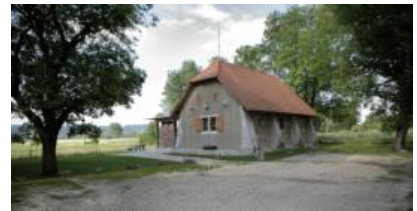
Pulverhaus, Ansicht nord ost
